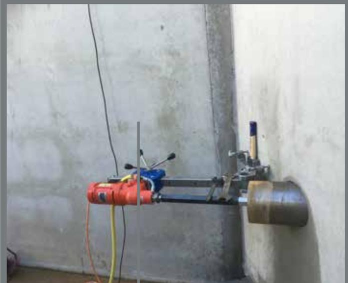
Bohrkernentnahme in einer Außenwand mittels tragbarem Handbohrgerät (d = 200)
