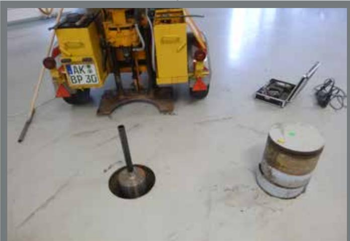
Bohrkernentnahme in einer Bodenplatte mit fahrbarem Straßenbohrgerät (d = 350mm)
